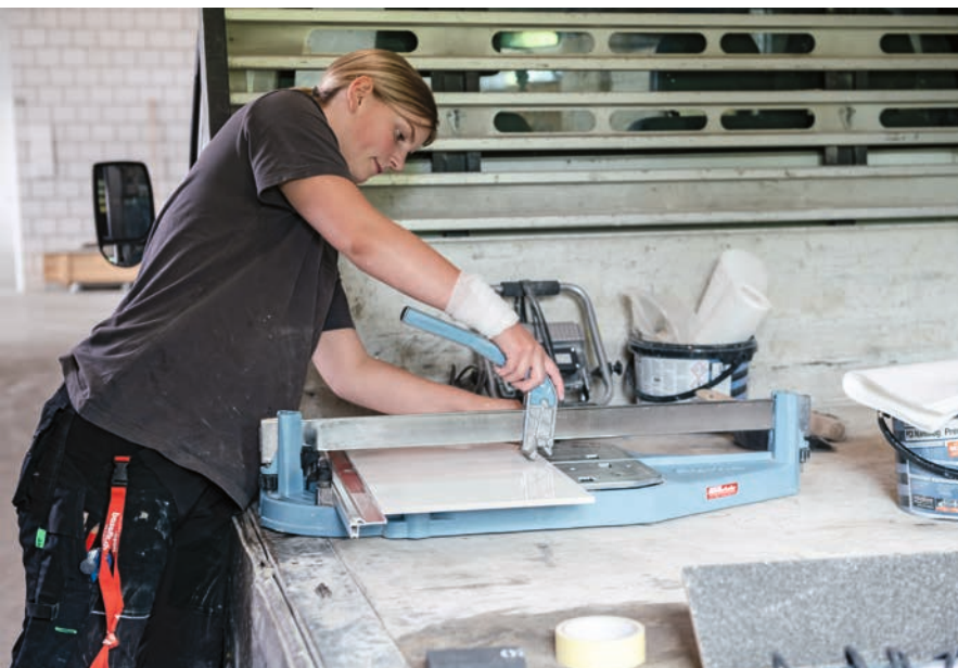
◀ Ronja Durand taglia le piastrelle ottenendo la forma e la dimensione di cui ha bisogno.
